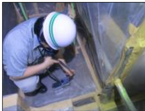
解体現場の立入検査の様子
