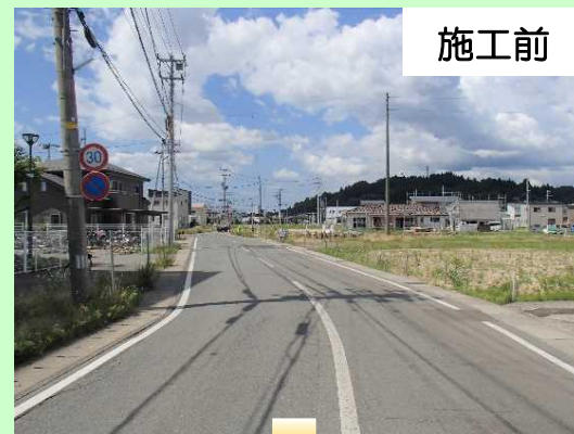
▶ 都市計画道路を築造しました (都市計画道路二ツ屋山崎線/幅員16m)
