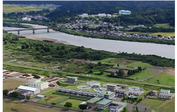
雄物川と仁井田浄水場（手前）、豊岩浄水場（奥）
