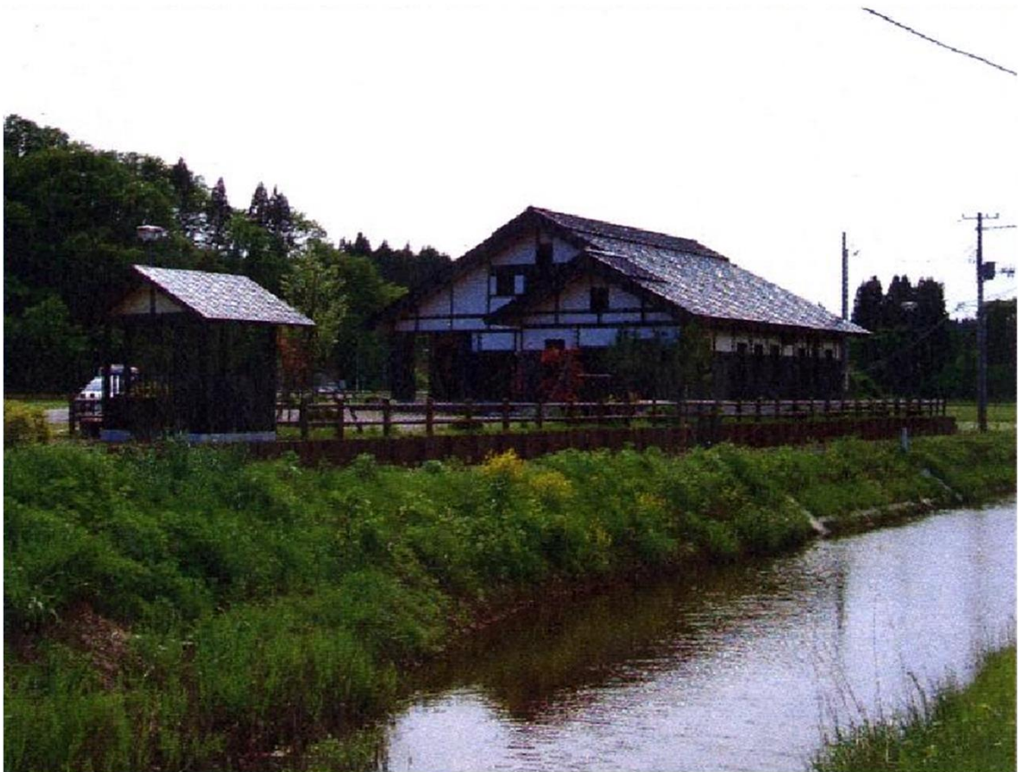
上北手東部農業集落排水処理施設
