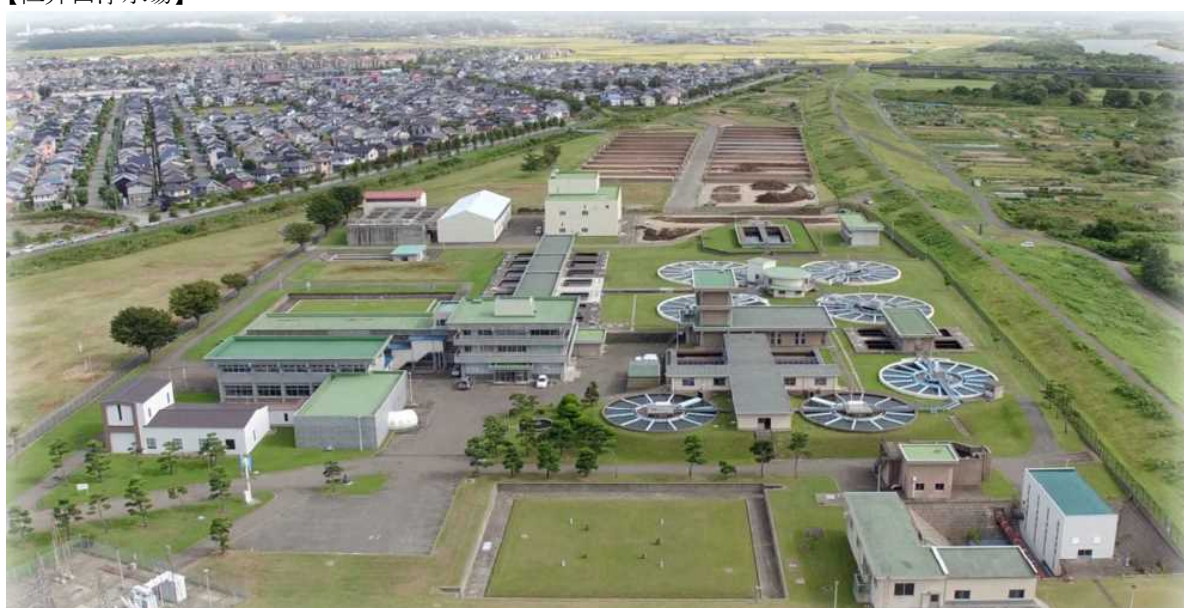
【仁井田浄水場】
