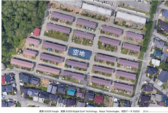
図 9-1 手形山市営住宅の立地状況
