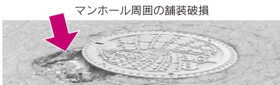
マンホール周囲の舗装破損
