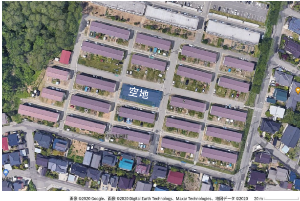
図 9-1 手形山市営住宅の立地状況
