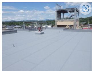
熱アスファルト防水工事
