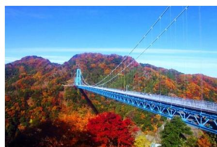
常陸太田市竜神大吊橋
