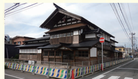
工事中の旧松倉家住宅
