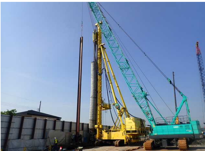
H形鋼建込状況
