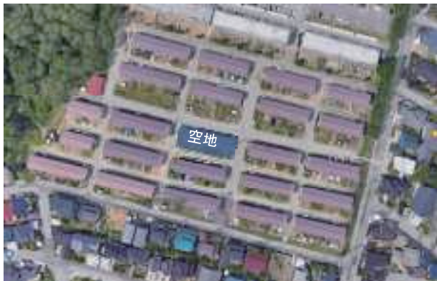
図 8-1 手形山市営住宅の立地状況
