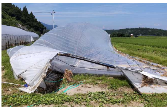
【倒壊したビニールハウス】
