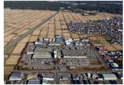
写真● 外旭川地区の状況
