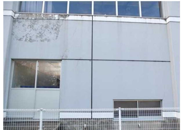
体育館東側外壁
