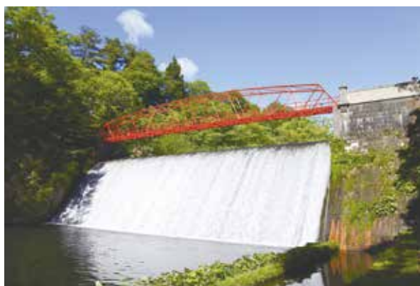
写真13 藤倉水源地水道施設
