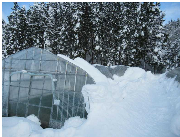
写真２ セリ用パイプハウスの倒壊（湯沢市）
