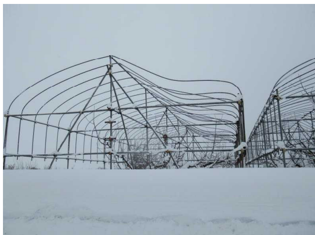
写真３ おうとう用雨よけハウスの損壊（湯沢市）
