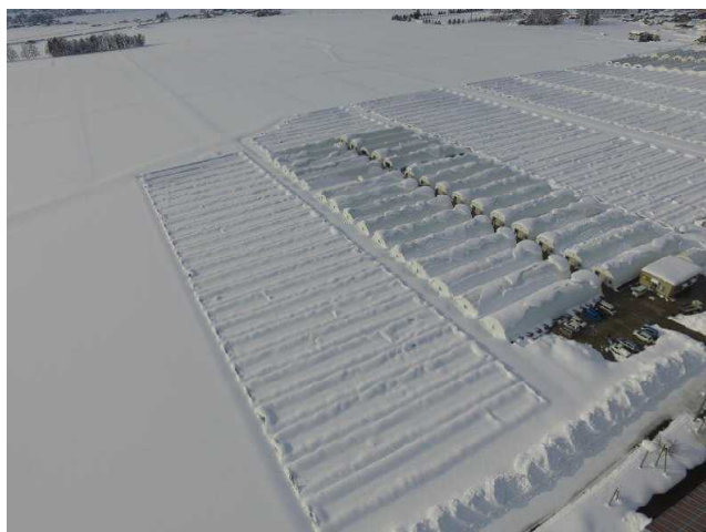
写真１ ほうれんそう団地のパイプハウスの倒壊（横手市）
