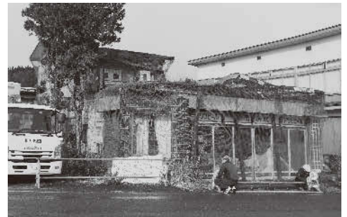
12月9日、解体工事に着手しました。 工事の完了は2月下旬頃の予定です
