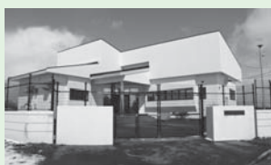
清水木ポンプ場
