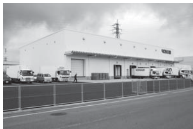
冷凍・冷蔵倉庫
