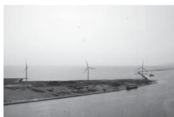
公有水面埋め立て予定地
