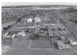
仁井田浄水場
