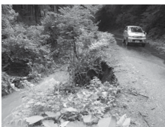
被災した林道湯の里線
