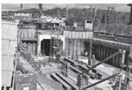
建設中の泉外旭川駅
