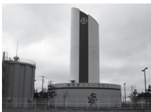
御所野配水場
