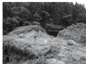
決壊した下浜地区の 下が沢上ため池
