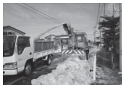
道路除排雪の様子
