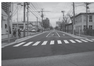
川尻広面線 歩道改良
