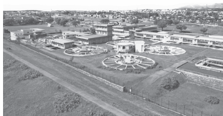
仁井田浄水場
