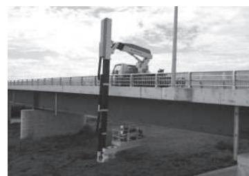
橋りょう点検
