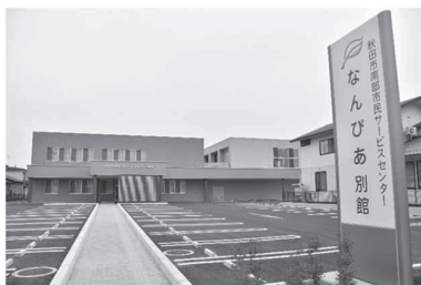
南部市民サービスセンター別館
