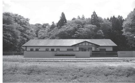
下北手中央農業集落排水施設
