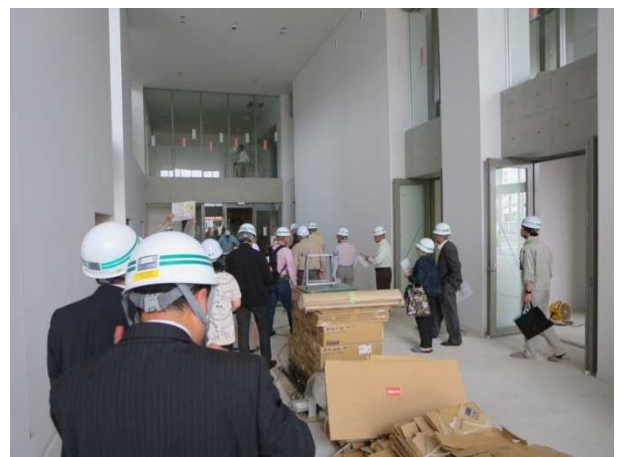
管理運営を予定している(仮称)土崎みなと街づくり協議会の皆さんによる施設の内覧
