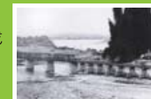
雄物川改修工事
