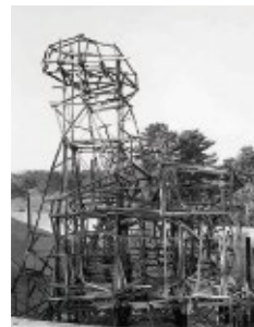
1980年 サル山築造工事
