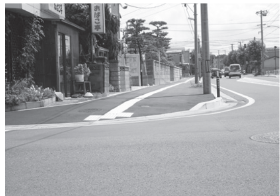
歩道の段差解消（土崎駅周辺地区）
