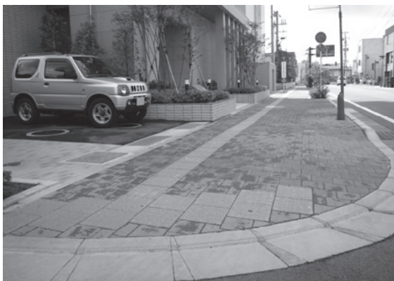
歩道の段差解消（秋田駅周辺地区）
