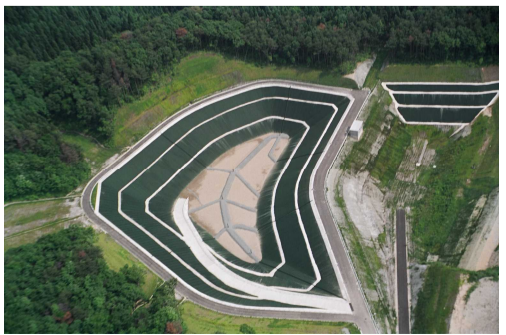
溶融炉導入で延命が期待される最終処分場
