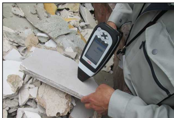
解体現場のパトロール検査風景
