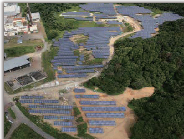
秋田市メガソーラー発電所
