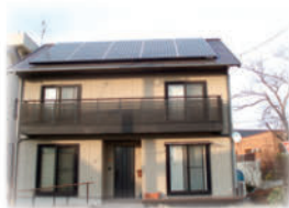
太陽光パネルを設置した住宅
