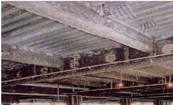
耐火被覆材：柱・梁
