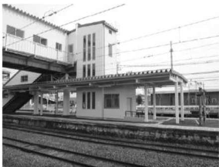
こ線橋の改築とともに、新たに設置されたエレベーター（上りホーム側）
