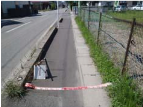
Aルート 1番 (狭い、点字ブロックがない)
