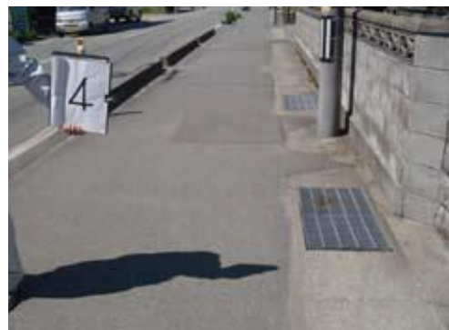
Lルート 4番 (グレーチング蓋の目が大きい)
