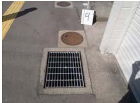
Hルート 9番 (グレーチング蓋の目が大きい)
