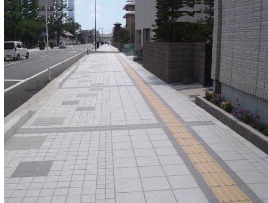
点字ブロックの改善（県道土崎停車場線）
