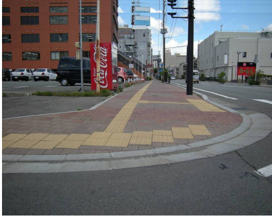
段差等の解消（市道大堰反線）
