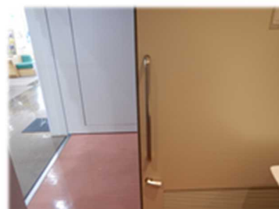
(鍵が手すりの下のみの扉)
