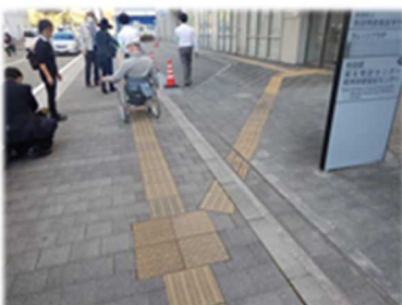
(建物まで連続した点字ブロック)
