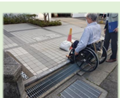
(歩道と駐車場敷地との段差)
