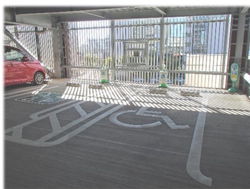
(路面が青色塗装されていない駐車区画)
