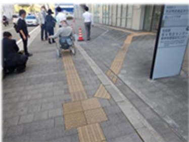
(建物まで連続した点字ブロック)
