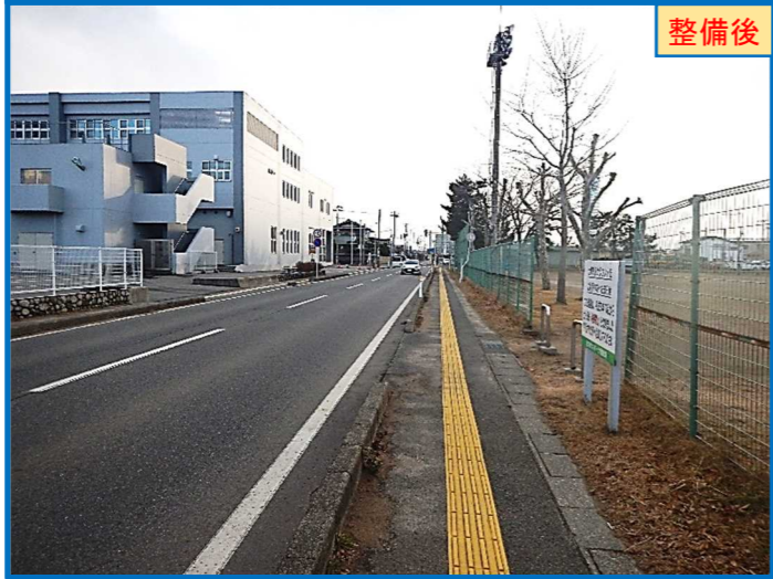
点字ブロックの設置
