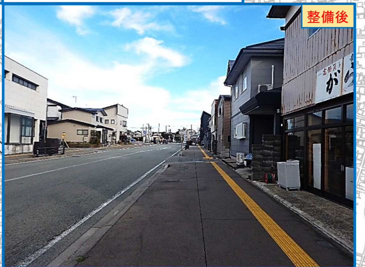
歩道の段差解消、消融雪設備
