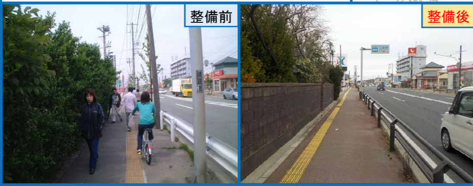
歩道拡幅、歩道の段差解消、消融雪設備 等
