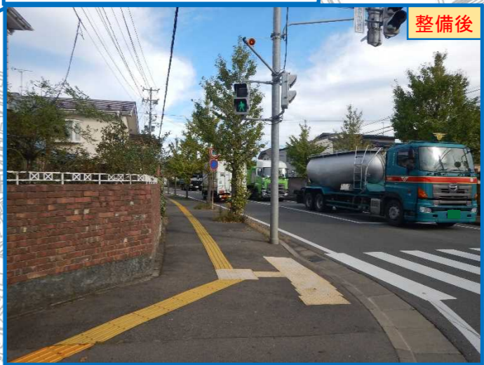
点字ブロックの設置
