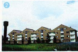
A. 県営住宅御野場団地
