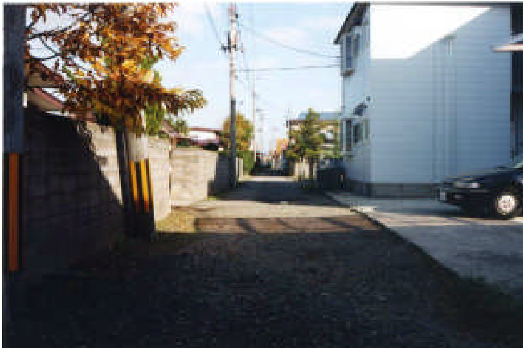
施工前 平成5年11月撮影
