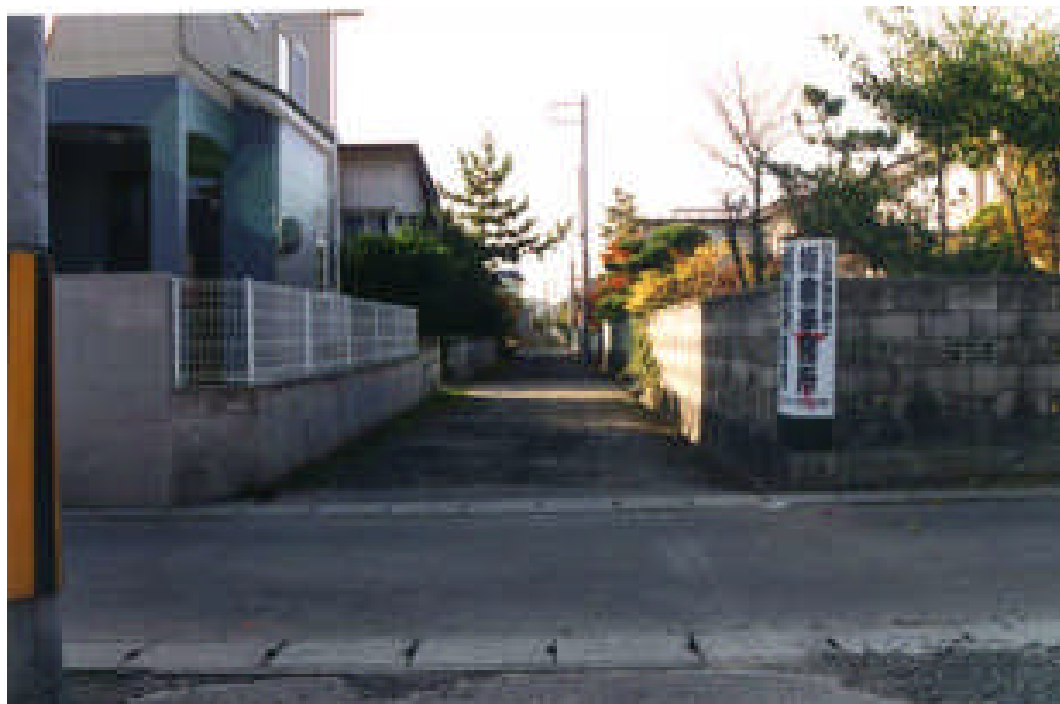
施工前 平成5年11月撮影
