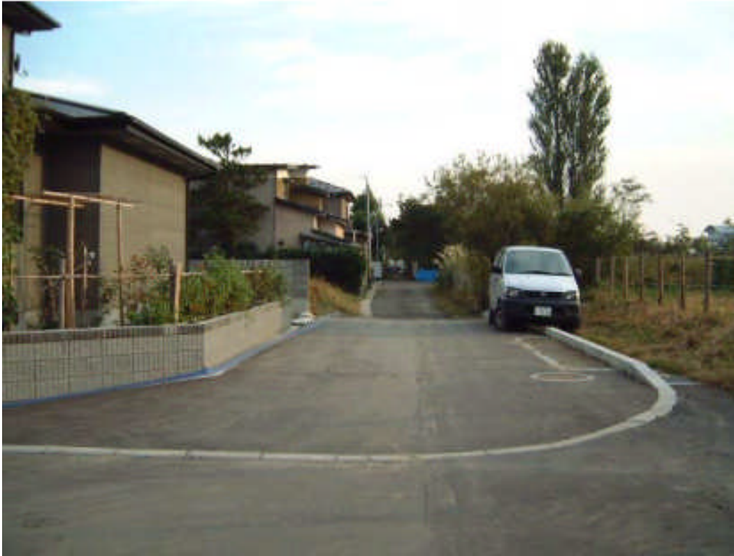
施工前 平成14年 撮影
