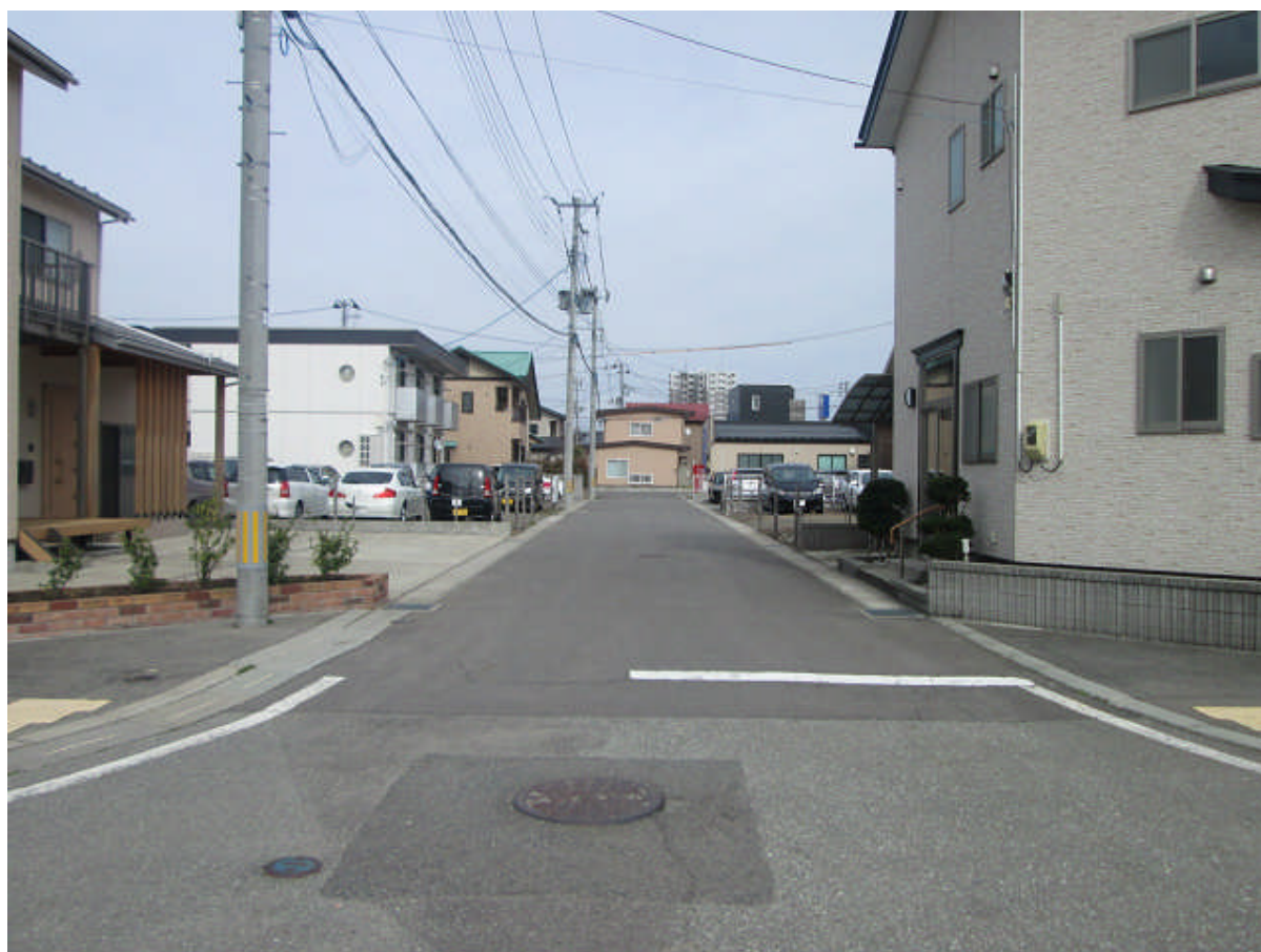
施工後 平成25年5月撮影
