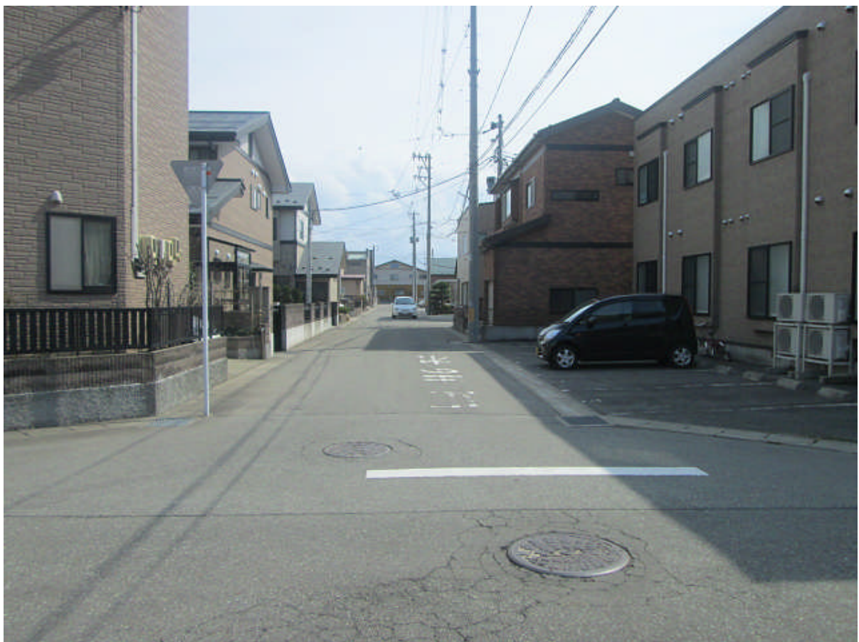
施工後 平成25年5月 撮影
