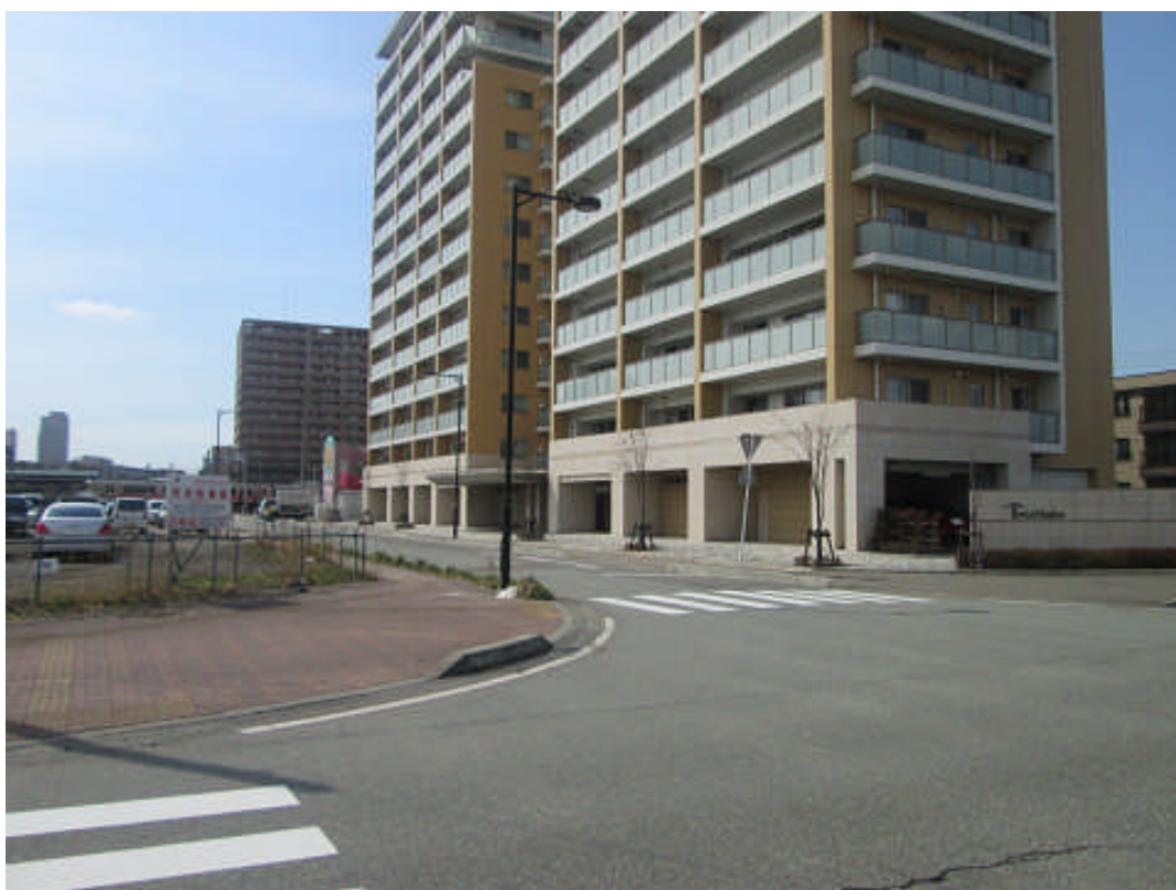
施工後 平成25年5月 撮影
