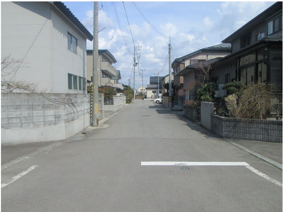
施工後 平成25年5月 撮影
