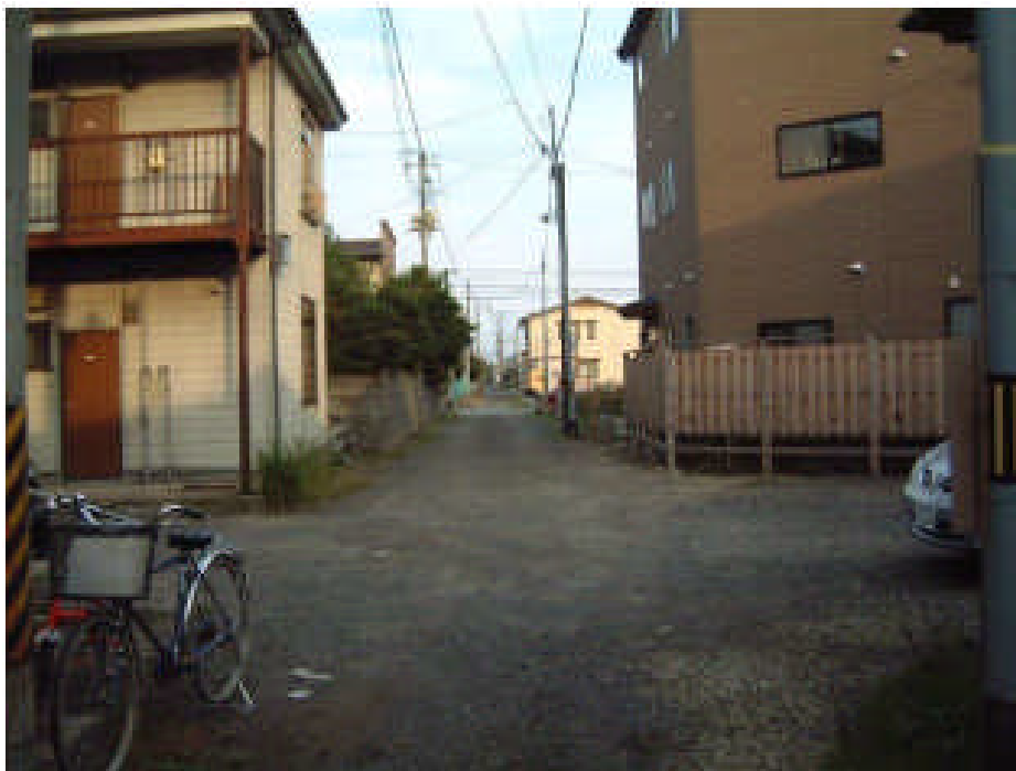
施工前 平成14年 撮影
