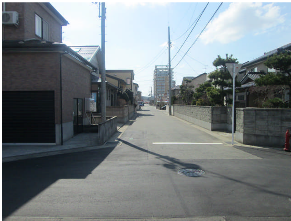
施工後 平成25年5月撮影
