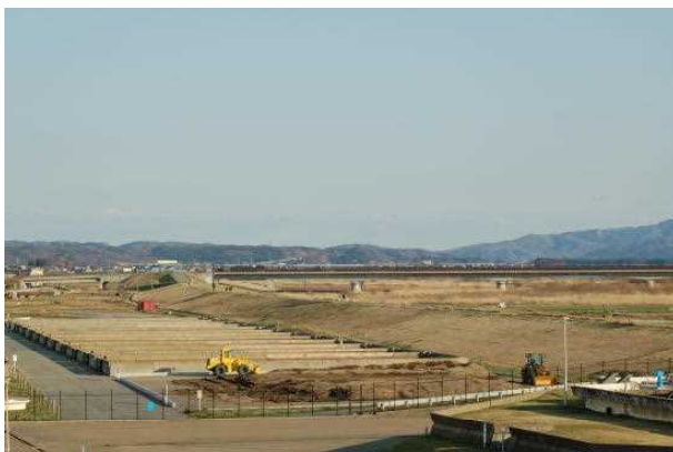
仁井田浄水場天日乾燥床
