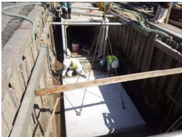
雨水幹線整備工事
