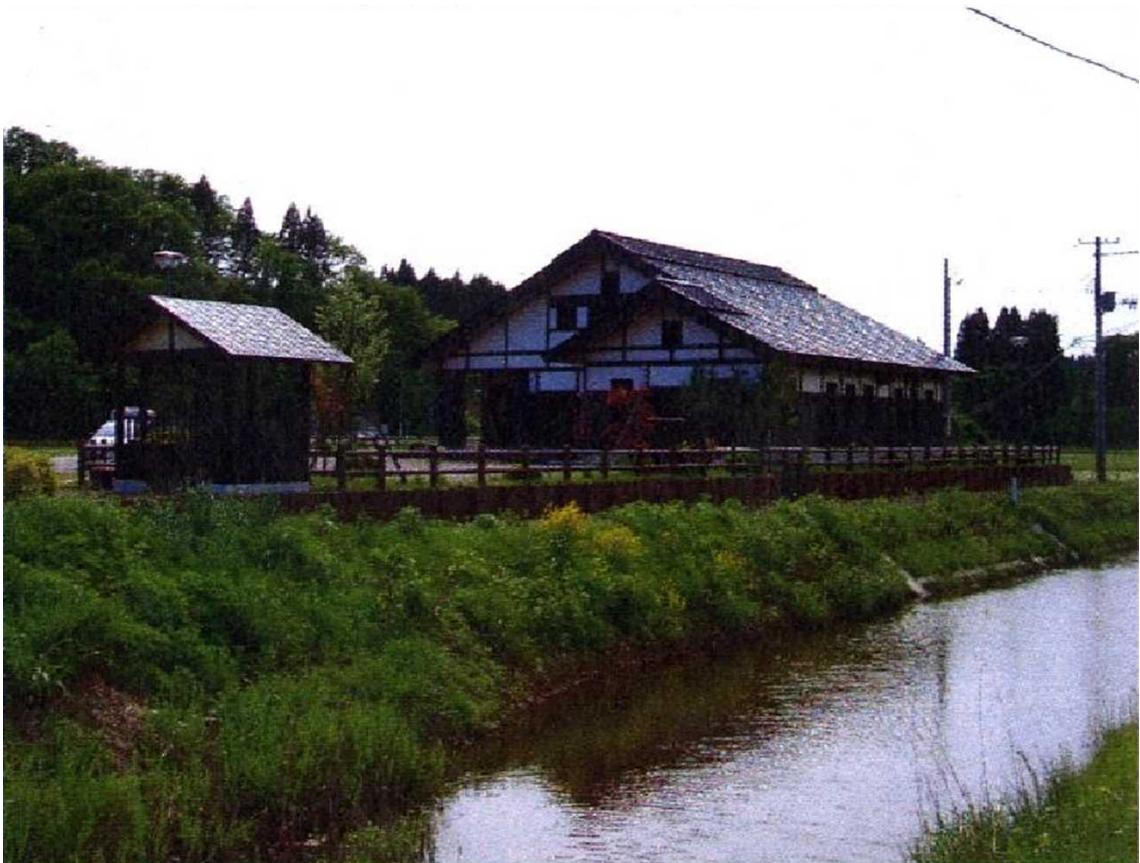
上北手東部農業集落排水処理施設
