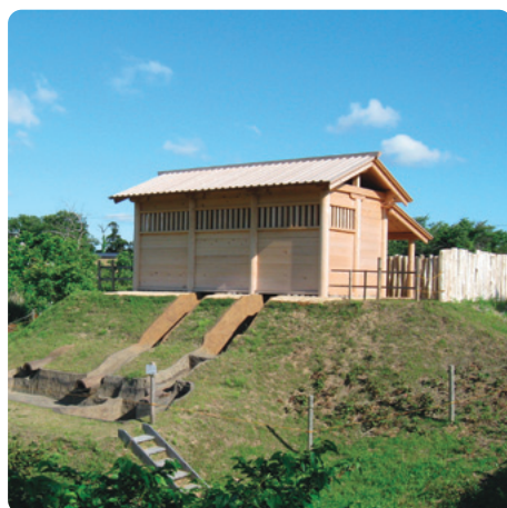
■復元された古代水洗厠舎
