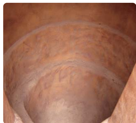
1 沈殿槽側から
