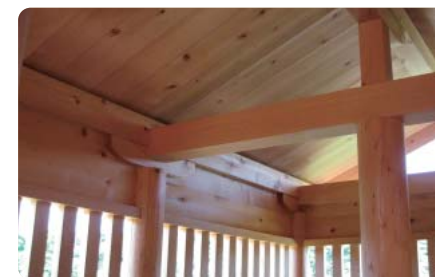
■格子窓・妻壁 採光と臭い抜きのために格子窓を設け、妻壁は付けていません。
