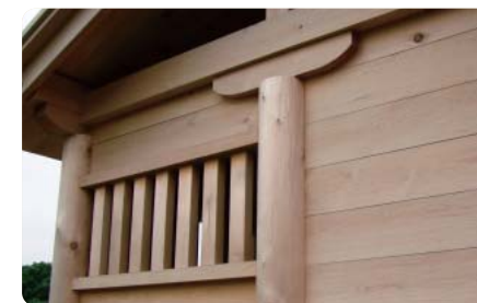
■柱 建物にはヤリガンナの仕上げ痕が残り、屋根は舟肘木で支えています。
