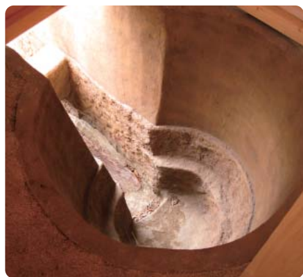
1 便槽のぞき込み
