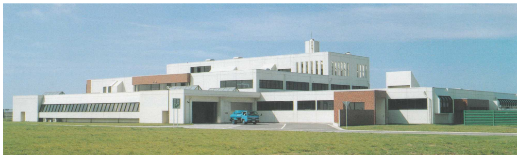
汚泥再生処理センター
